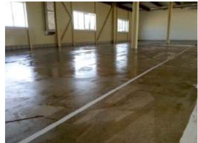
Нанесение материала следует осуществлять в специальной обуви – мокроступах. Обычная обувь может оставить следы на поверхности.
