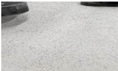
Результатом грубой шлифовки является равномерное открытие наполнителя. В процессе шлифования необходимо контролировать толщину снимаемого слоя. Для этого необходимо взвешивать количество снятого состава (в виде пыли из пылесоса).
