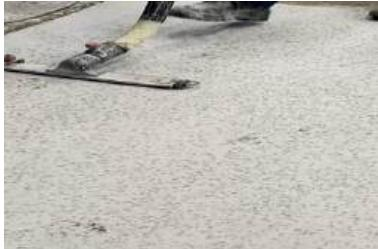
После процесса обеспыливания необходимо провести визуальный осмотр поверхности. При обнаружении на поверхности трещин и пор на поверхность наносится Linolit® 11 - состав применяется в качестве заполнителя пор и швов, для сухих бетонных оснований. Приготовленный материал Linolit® 11 распределяется по шву с помощью шпателя. Время полимеризации – 5-7 минут.
