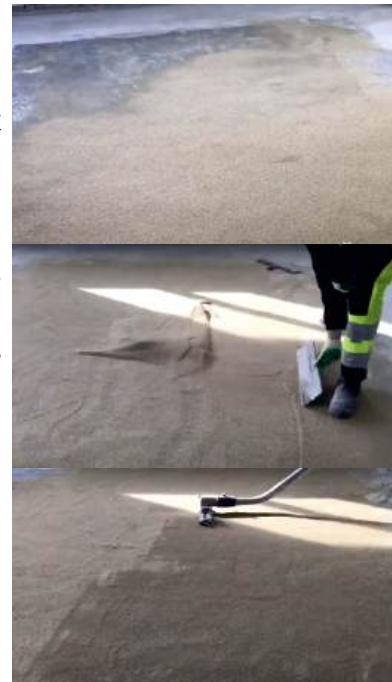
После нанесения материала необходимо следить за отсутствием загрязнений на поверхности. Ограничить доступ людей до полного завершения процесса полимеризации.
